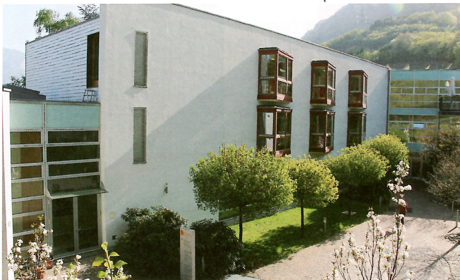
Hier entsteht der Zubau gegen den Innenhof. Zugang zur Kapelle und Haupteingang bleiben unverändert.
