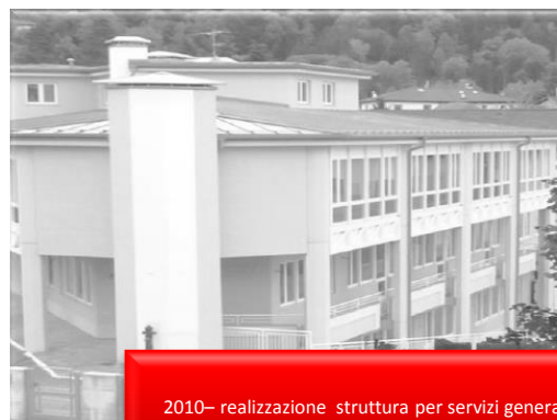
2010 – realizzazione struttura per servizi generali
